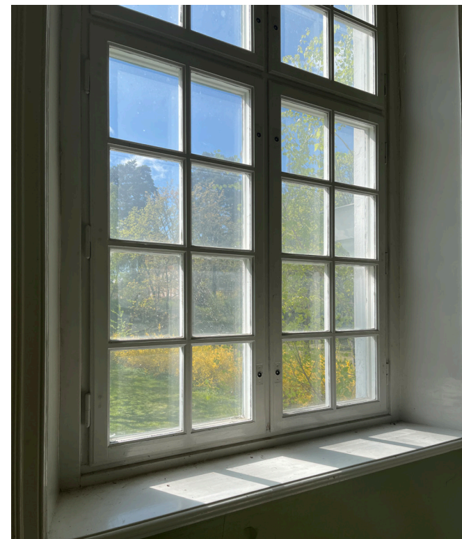
Bevarat småspröjsat fönster i trä.
