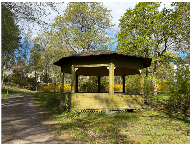
En sannolikt ursprunglig paviljong på det område som tidigare utgjorde patienternas rastgård. Tidigare fanns ett flertal liknande paviljonger utspridda i parken runt sjukhuset men denna är den enda som finns kvar idag.
