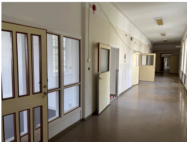
Flertalet äldre byggnadsdetaljer är borttagna på plan 2 som dörrar, dörrfoder och golvmåter. Dock finns ursprungliga detaljer kvar så som stuckatur, ursprungliga fönster samt snickerier.
