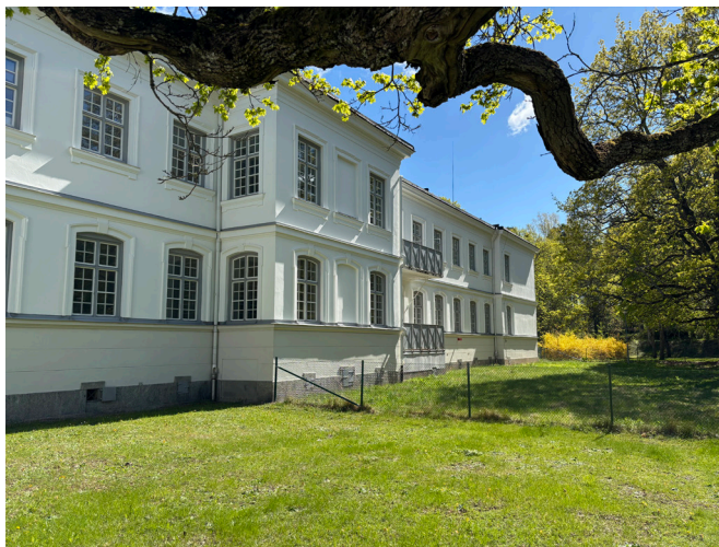
Byggnadernas symmetriska uttryck är typiskt för arkitekturen under 1800-talets slut. Det är ett bärande karaktärsdrag för nyklassicismen.
