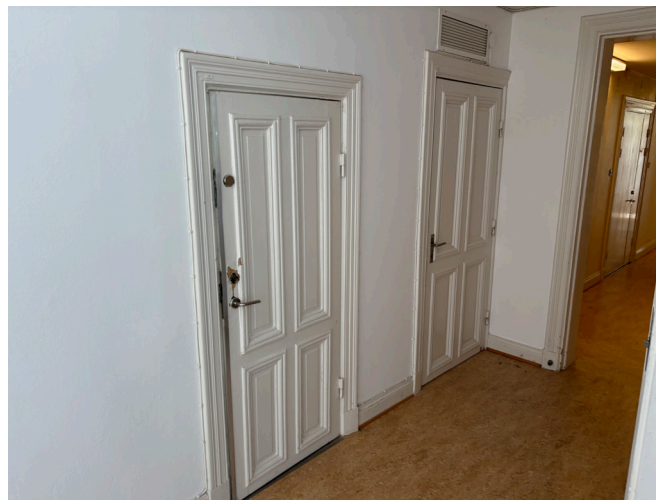
Ursprungliga dörrar med tillhörande snickerier i form dörrfoder ansluten via skurstock till golvsöcket.
