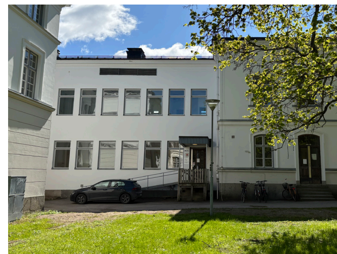
Förändrad fasad och entré vid mittbyggnadens norra fasad.
