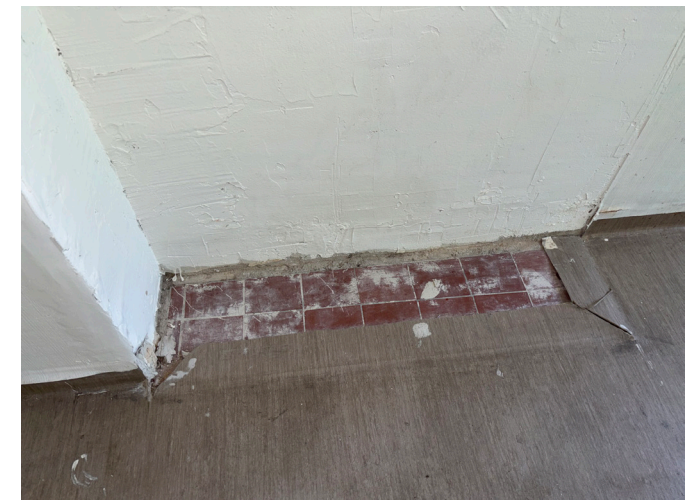
Sannolikt ursprungligt golv, här i form av klinker under befintlig plastmatta.
