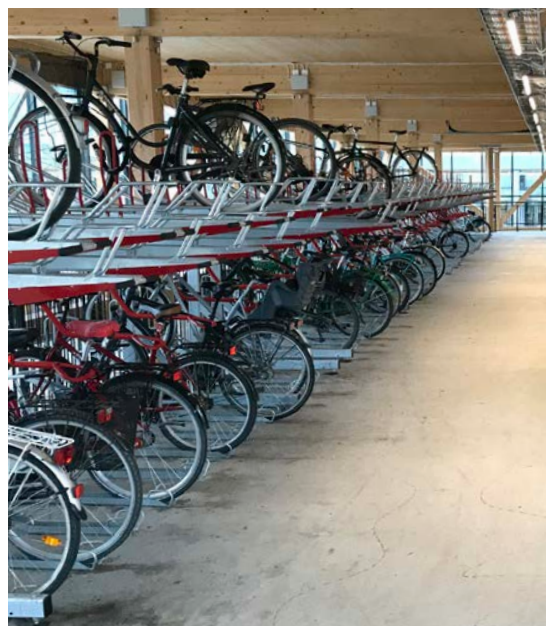
Interiör från Cykelparkeringshuset vid resecentrum
