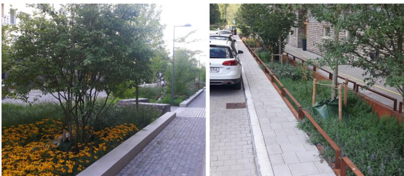
Exempel på nedsänkt växtbädd i gatumiljö med inlopp via kantsten (Norra Djurgårdsstaden). Källa: VA-Verktyget
