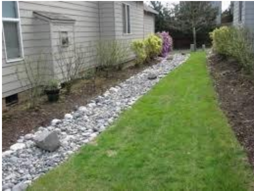
Figur 23. Gräsbevuxet makadamdike med dräneringsledning i botten. Att använda vid de villatomter vars baksida vetter mot annan tomt. Till höger exempel med bräddfunktion via brunn. Foto och illustration: Bjerking.
