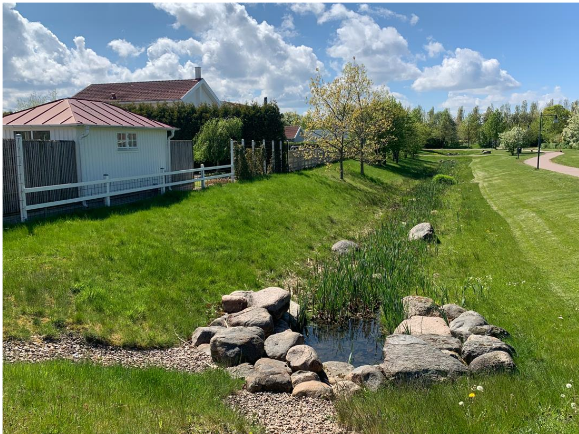
Figur 24. Lågstråk med dike. Tack vare slänternas utformning kan stora volymer fördröjas i stråket vid stora regn. Foto: Bjerking.
