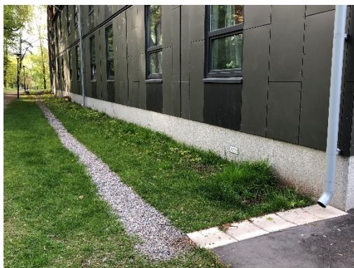
Figur 19. Exempel på öppet makadamdike för avledning av dagvatten till infiltrationsstråk (Foto: Bjerking. Illustration: WRS).
