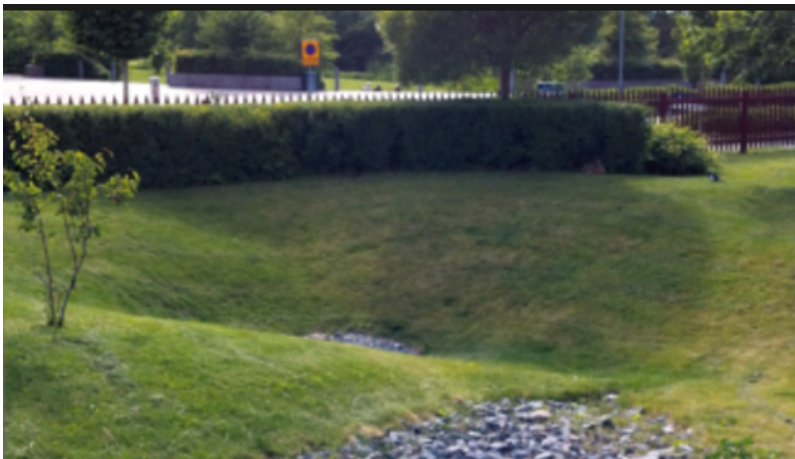
Figur 23. Torrdamm i form av nedsänkt gräsyta som fördröjningsyta vid skyfall. Foto: Bjerking.
