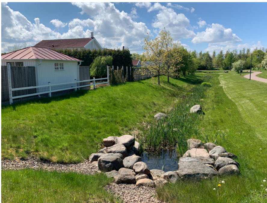
Figur 26 Lågpunktsstråk med dike föreslås som dagvattenlösning vid flerfamiljshusen. Utformning av slänterna medför att stora volymer kan fördröjas i stråket vid häftiga regn
