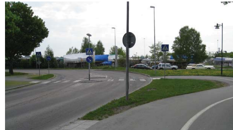
Östra Ågatans anslutning till Kungsängesplanaden, nuvarande utformning (Foto Bjerking AB)
