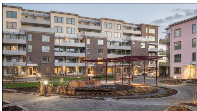
Figur 5-4. Avledning av takvatten till planteringar via rännदार anlagda i gatan. Exempelbild från Linnéhuset i Uppsala (Källa: Uppsalahem).
