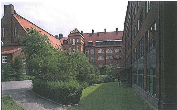
Lärarseminariets nordvästra fasad med tillbyggnaden från 1994 till höger (foto: Lennart Engström, Upplandsmuseet).
