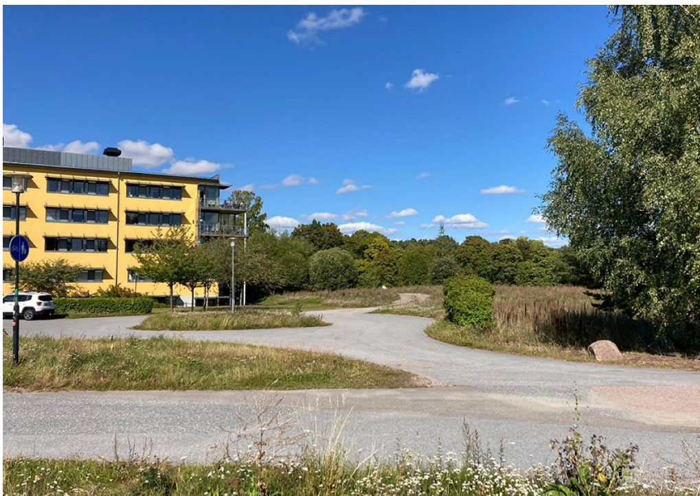
Bild 9. Foto som visar den vändplats som ligger i änden av Polacksgatan. (Augusti 2024)
