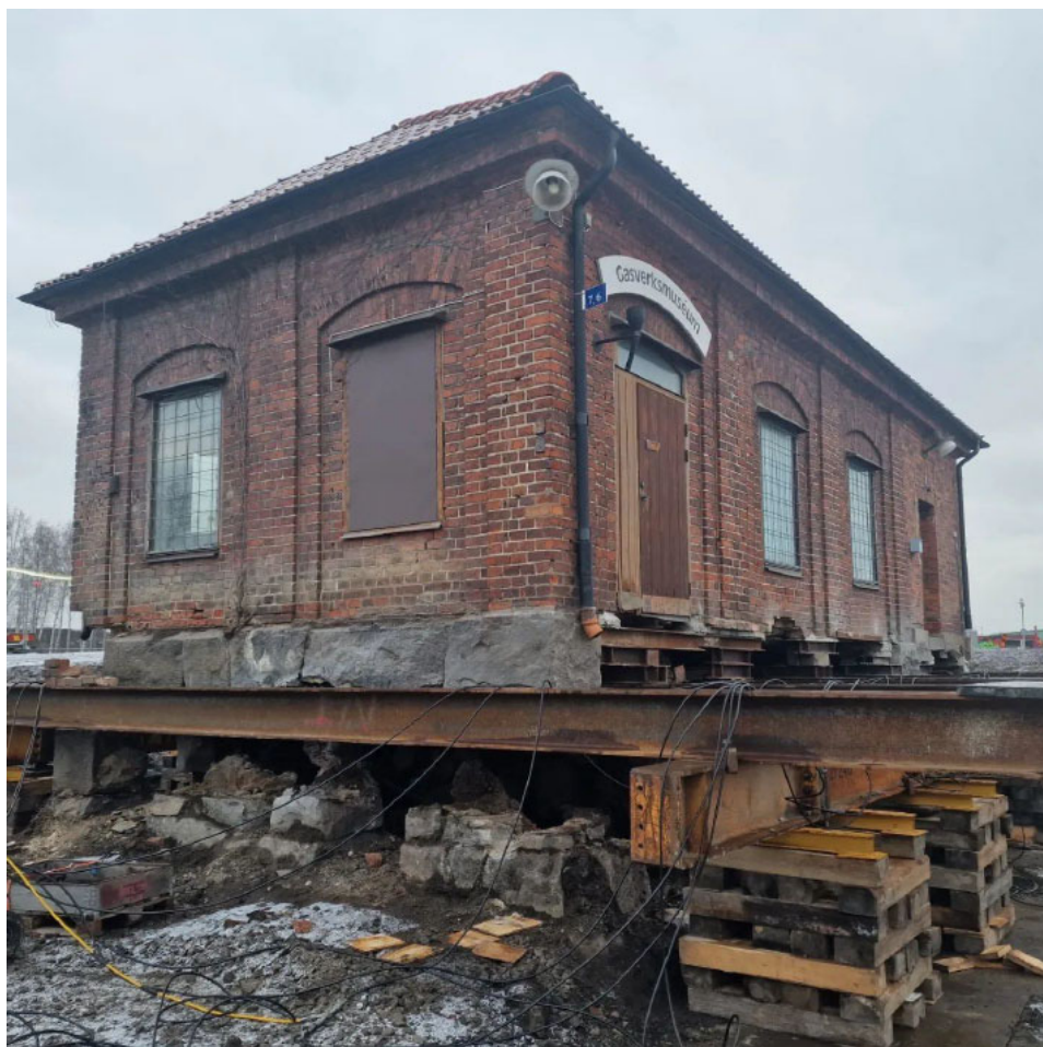
Figur 12. Bilden visar flytt av en byggnad med löst sammansatt grundmur. Flytt av gasmästarkontoret i Norrköping. Foto: Trafikverket
