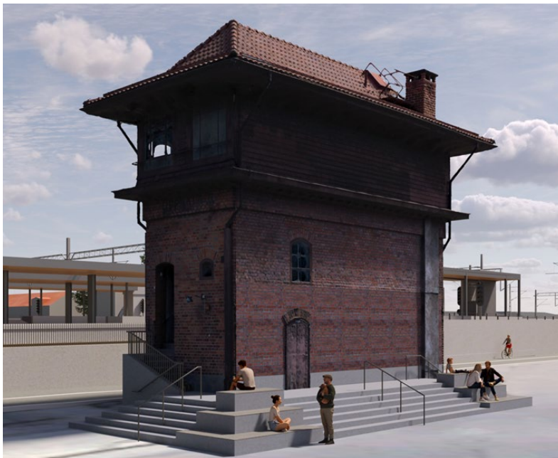
Figur 1. Illustration på ställverket efter flytt till ny placering.
