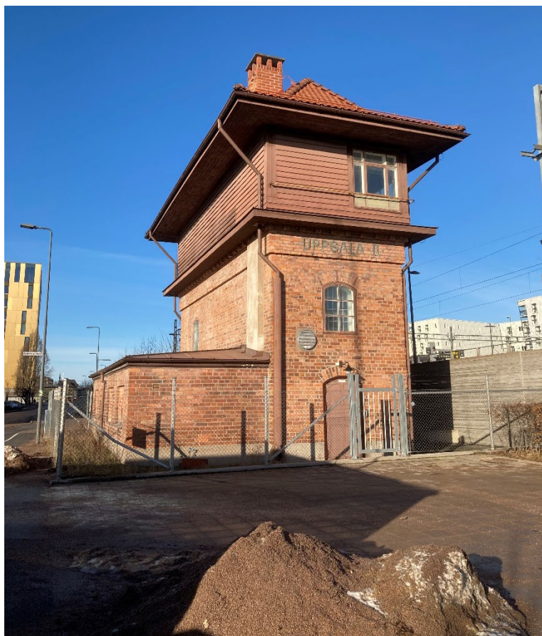
Figur 7. Ställverket är idag placerat intill järnvägen och är instängslat.
