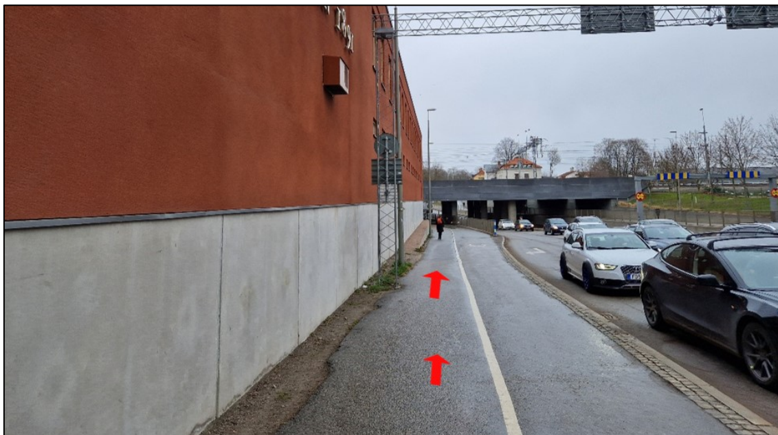
Figur 17. Strandbodgatan. Dagvattnet avrinner mot viadukten under järnvägen där vattnet ansamlas innan det bräddar söderut på Strandbodgatan.
