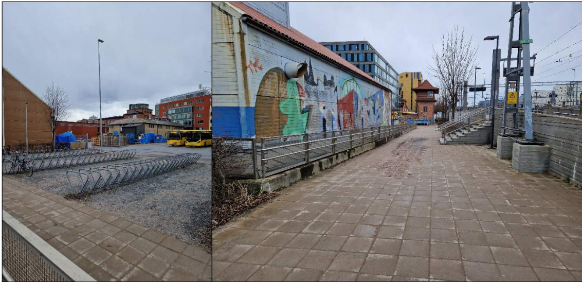
Figur 7. Bilder från platsbesök 2024-04-24. Till vänster visas befintlig cykelparkering och till höger redovisas befintlig gång- och cykelväg. Samtliga ytor ska rivas och ersättas.
