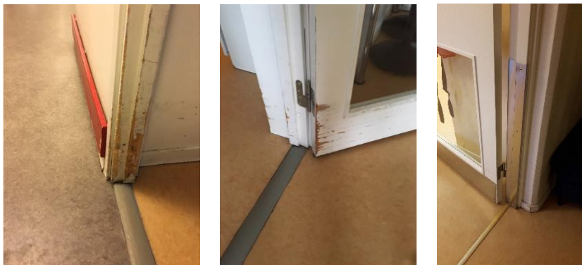
Figur 2: Oskyddade och skyddade dörrkarmar
