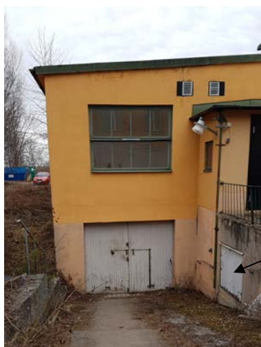
Figur 3. Nedfart till garaget i källaren samt luckan till utrymmet för cisternerna.
