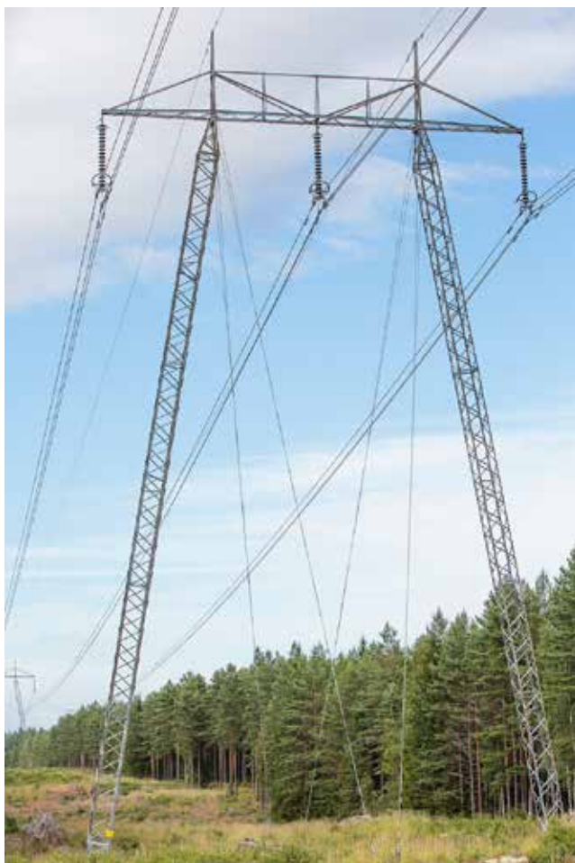
Figur 2.3. Exempel på portalstolpar. Stagad A-stolpe (till vänster). Ostagad B-stolpe (till höger).
