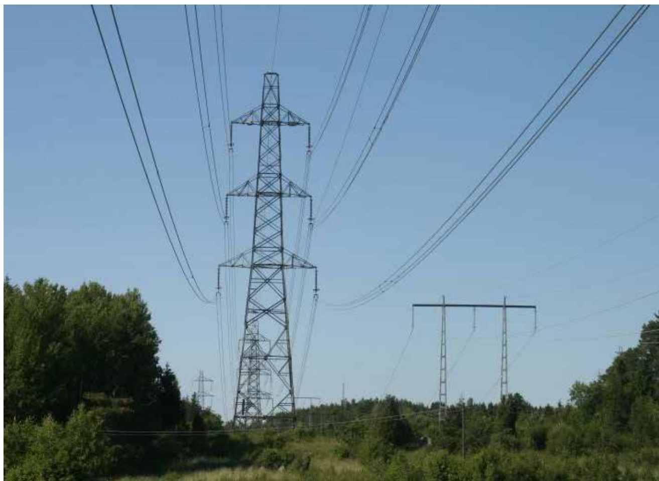
Figur 2.5. Illustration av julgrensstolpe i stål (till vänster) bredvid en portalstolpe (till höger). Den vänstra ledningen i julgrensstolpen är duplex (två linor) och den högra är triplex (tre linor).
