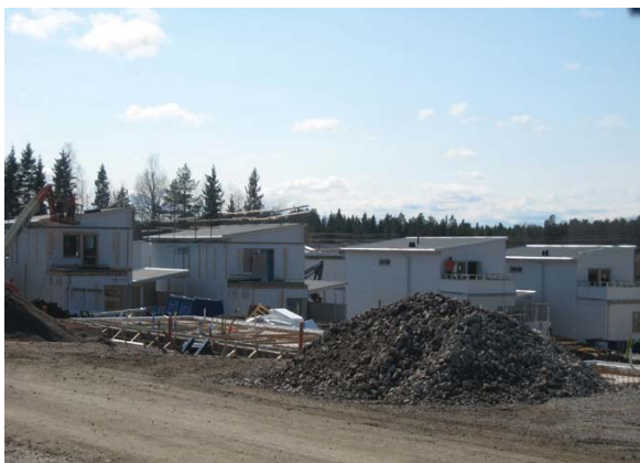
Vretalund under uppbyggnad.
