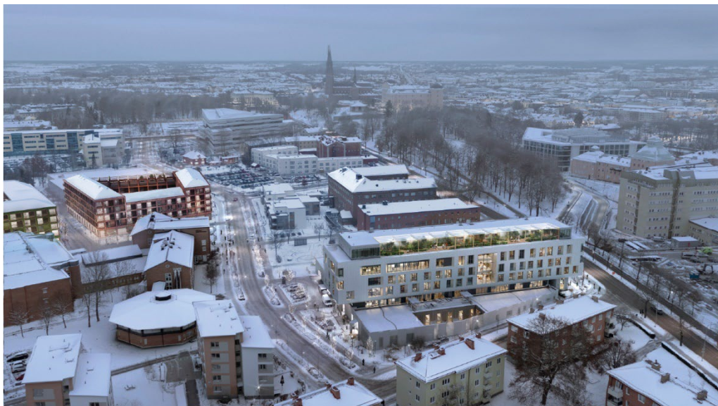
Figur 1. Översiktsvy över Blåsenhusområdet som visar ett exempel på hur delar av detaljplanen kan komma att genomföras. (Bild: White)
