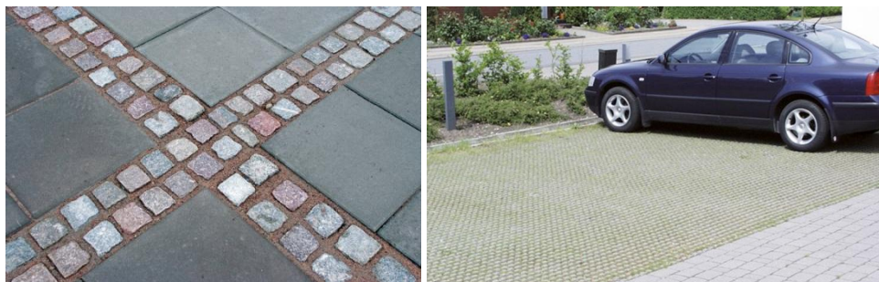
Figur 17. Gles plattsättning med sandfog och gräsarmering är två ytbeläggningar som minskar avrinningen.
