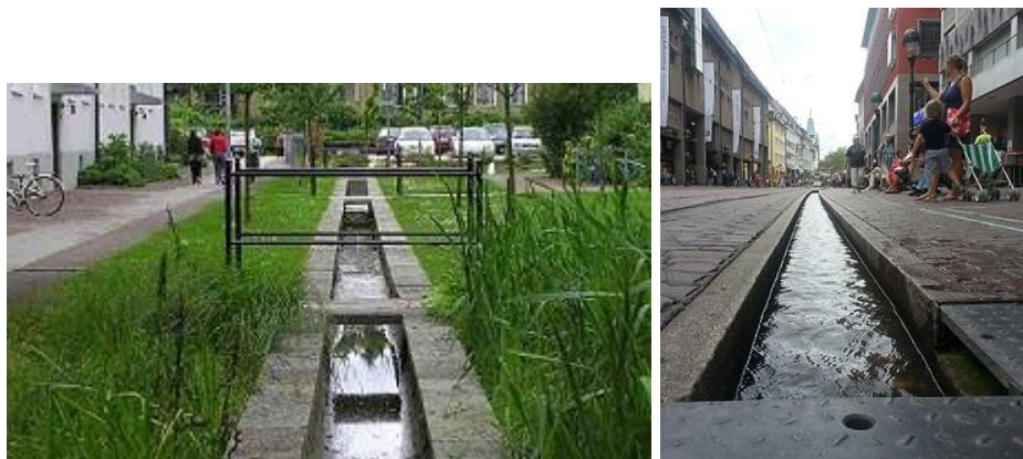
Figur 9. T.v. Dagvattenkanal med vegetationsytor på sidorna (Bild från VA-syd). T.h. Avrinning i öppen ränna i gaturummet.
