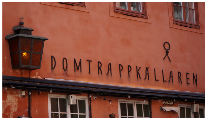
Skylt på särskilt värdefull byggnad.
