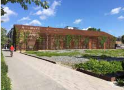
Exempel på inbyggd nätstation, Kungsängen Uppsala
