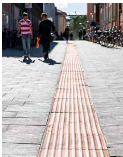
Längs Dragarbrunnsgatan och angränsande gränder anger räfflade taktila plattor av corténstål kommunikationsriktningen.
