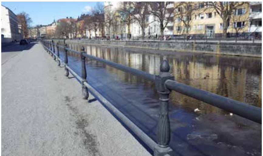
Längs Fyrisåns bägge sidor finns ett gediget, ornamenterat räcke av gjutjärn.
