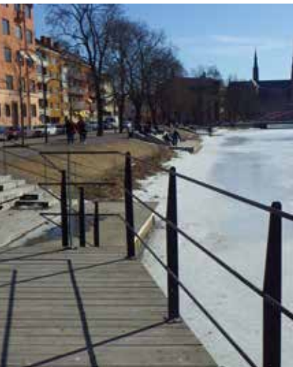
På bryggorna används moderna järnstaket.
