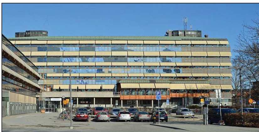
Den sydöstra fasaden anspelar på himlen mot norr. Emaljkonstverk går i olika kalla blå toner.
