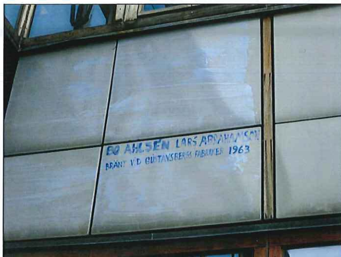
Fig 2. Signerad plåt ovanför terrassdörren, sydöstra fasaden
