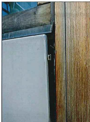
Fig 3. Infästning. Lossnad plåt
