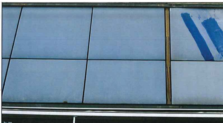
Fig 6. Sydöstra fasaden, smutsavlagringar på panelernas nederkanter och därmed förknippade rostangrepp
