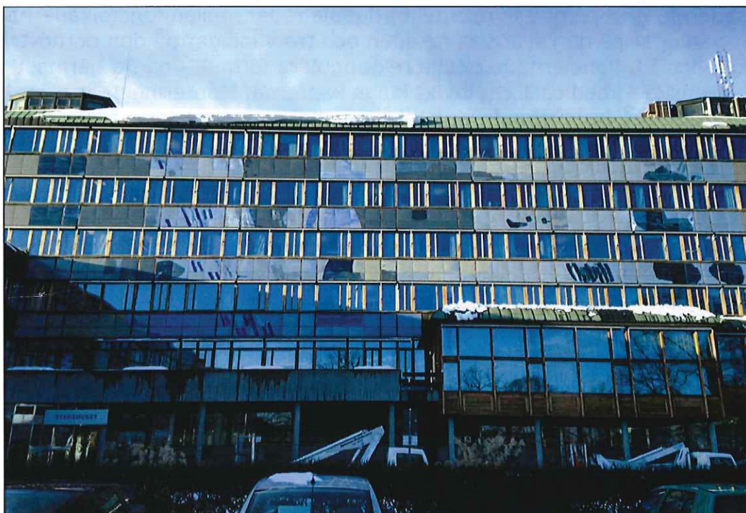
Fig 1. Sydöstra fasaden av Stadshusets sexvånings "huvudflygel"
