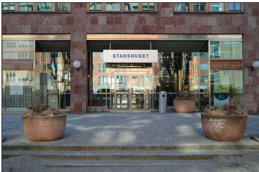
Det var ursprungligen tänkt att entréhallen skulle vara öppen mot innergården, men av klimatskäl glasades den in. Huvudentrén skulle annars vara mot järnvägsparken.
