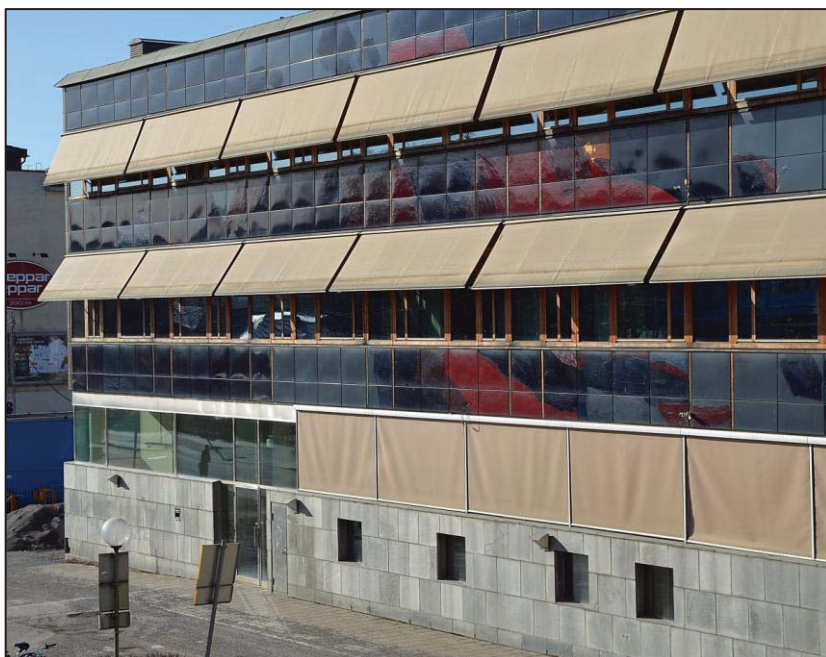
Den sydöstra fasaden anspelar på himlen mot väst, dit blicken går när man betraktar fasaden. Emaljkonstverk går i solnedgångens röda och mörkblå toner.
