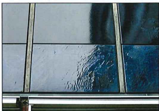
Fig 4. Några dekorerade paneler, nordost fasaden
