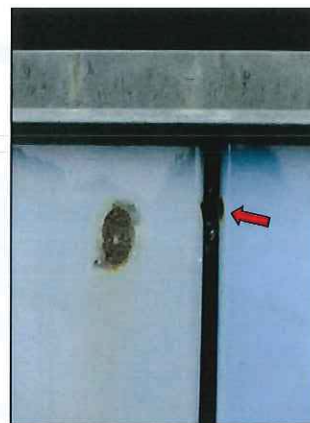
Fig 7. Skador invid infästningar (röd pil) och avslagen emalj
