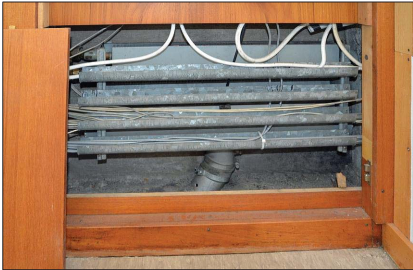
Bröstningskåp med kablage.
