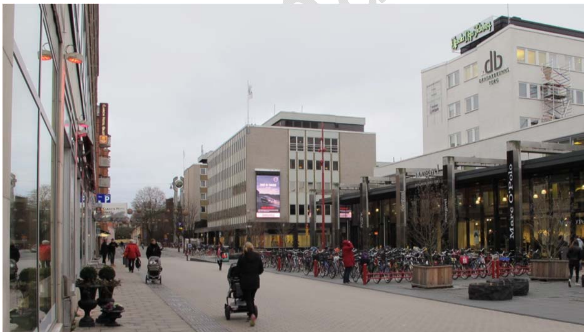
Foto som visar planområdet idag. Kontorsbyggnaden med reklamskylt på fasaden föreslås rivas och ersättas med en ny biografanläggning.
