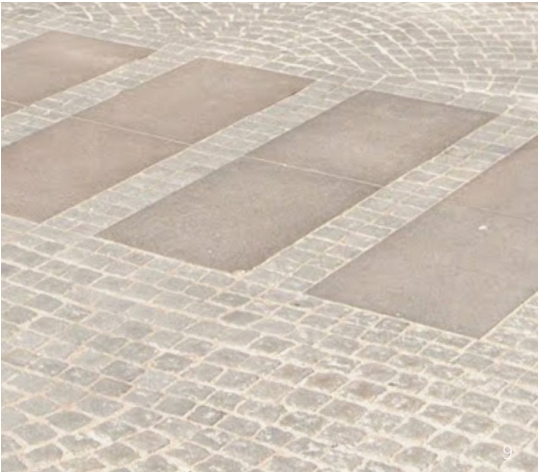
Inslag av granithällar i smågatstenen ökar tillgängligheten samtidigt som att ytan upplevs som ett sammanhållet golv.
