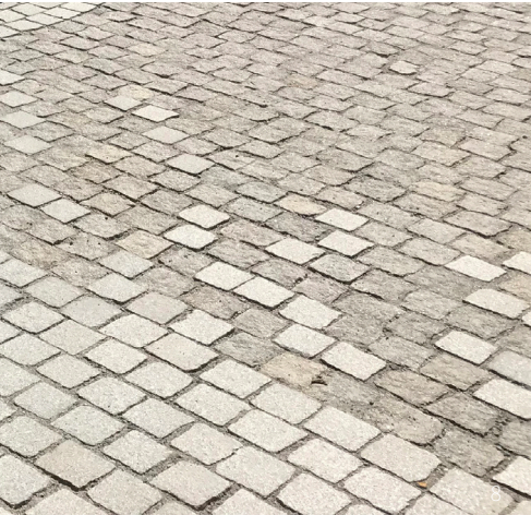
Flammad/sågad smågatsten kan med fördel användas på ytor som kräver högre tillgänglighet för rörelsehindrade.
