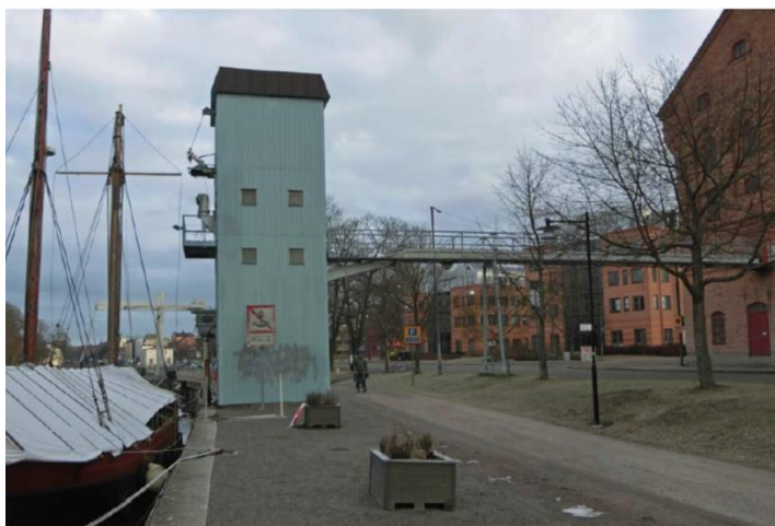
Skeppselevatorn. Foto Upplandsmuseet.
