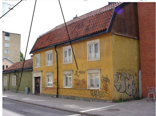
Befintliga trähus längs Vretgränd som skall bevaras och renoveras.
