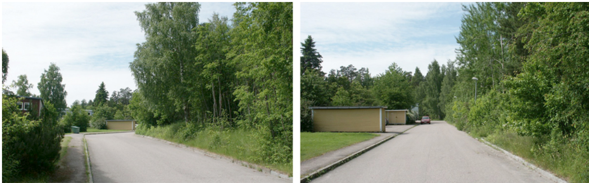
Källarbäcksvägen, vy mot sydväst. Planområdet till höger i bild.
