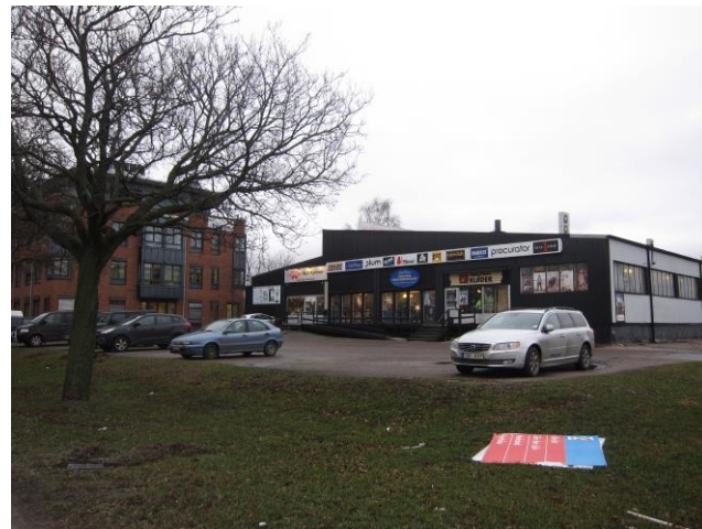
Befintlig byggnad sett från Kungsgatan
