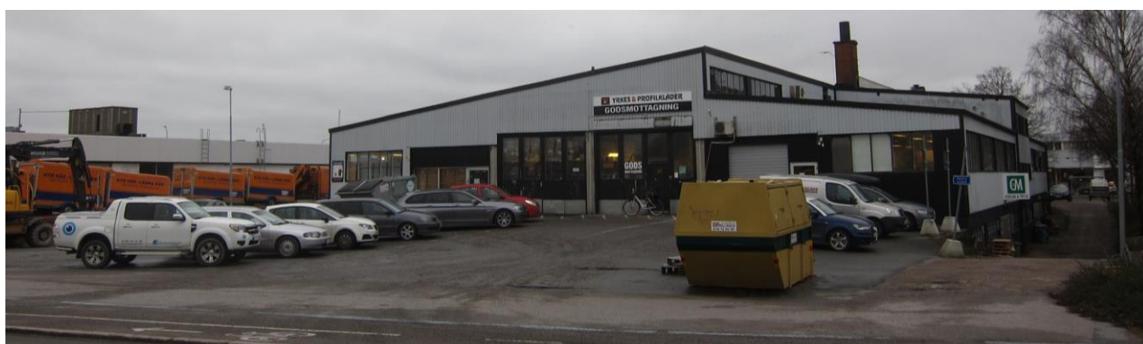
Befintlig byggnad sett från Vimpelgatan
