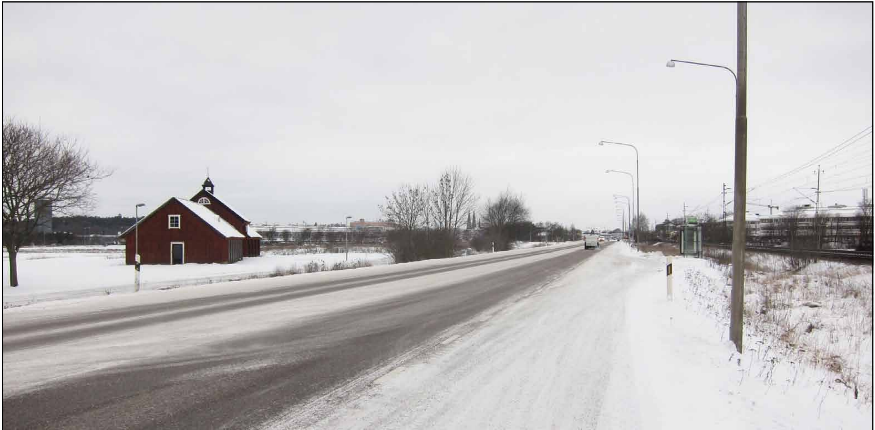
VY 2 FRÅN GAMLA STOCKHOLMSVÄGEN - BEFINTLIGA FÖRHÅLLANDEN
