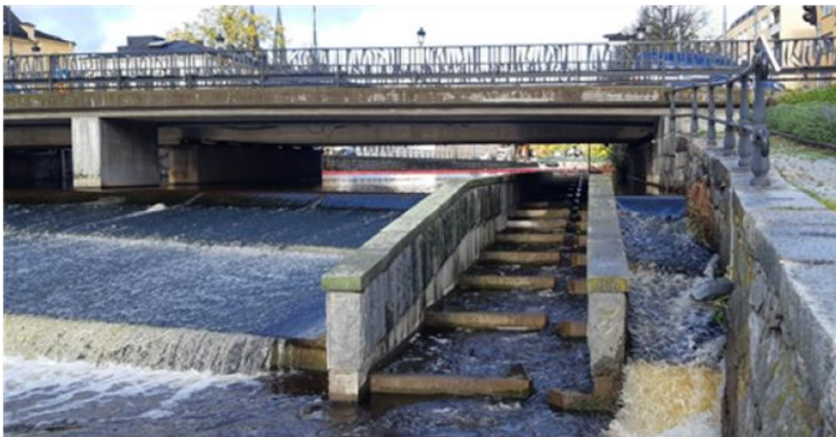
Figur 15. Asptrappan under Islandsfallet. Foto WSP Sverige AB
