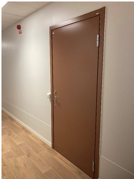
Figur 2: Exempel på en hög avbärarlist som påkörningsskydd som skapar ett hemligt intryck, källa Uppsala kommun.
