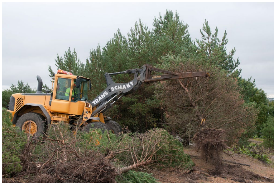
Figur 18 Maskinell uppryckning av tall Röboåsen 2013. Uppryckning med rötterna skapar förutom en ökad solinstrålning även en önskad markstörning. Røjning där stubbarna blir kvar ger inte alls samma positiva effekt för åsfloran.
