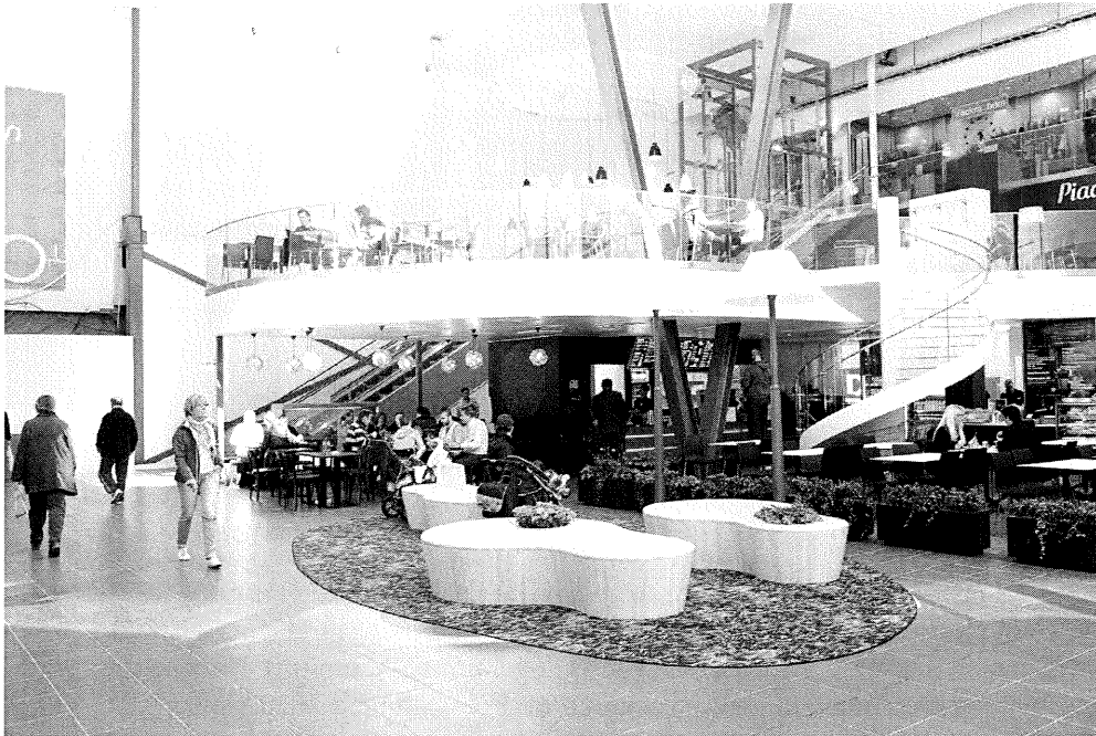
Interiör från Gottsunda centrum som är under om-och tillbyggnad.
