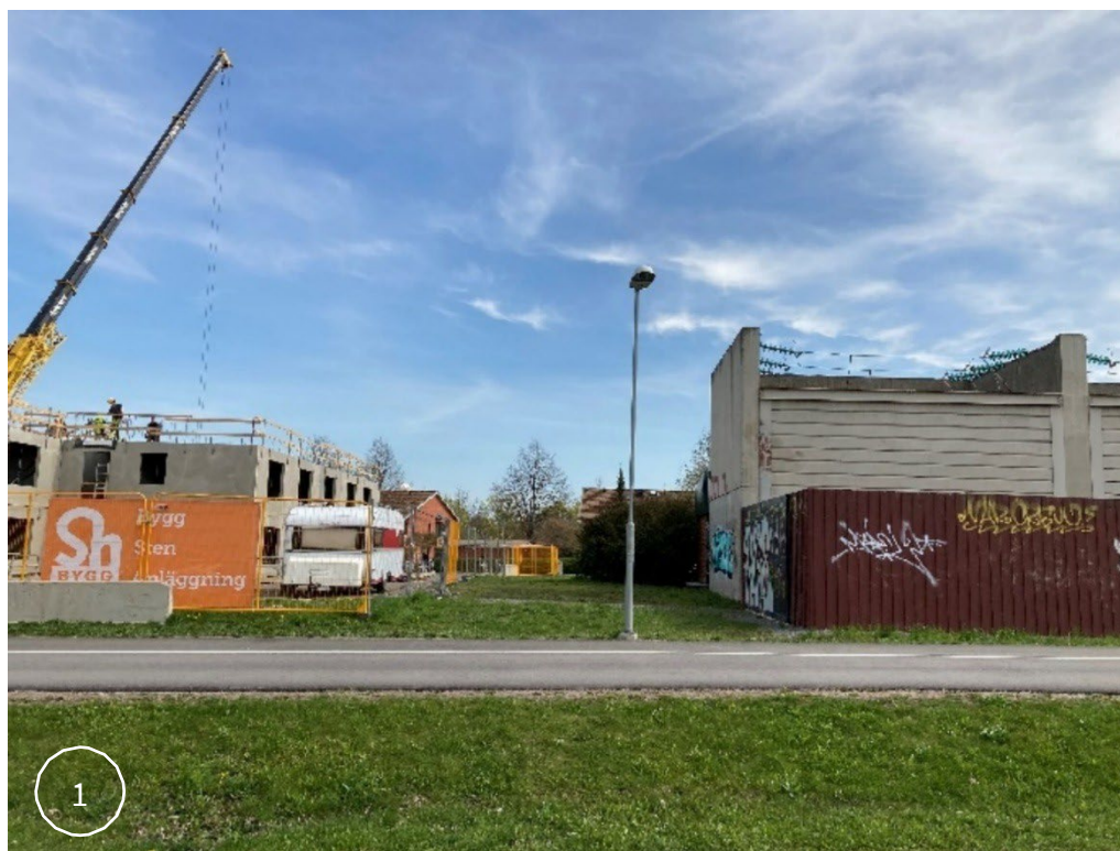
Figur 6, nytt bostadshus under uppförande till vänster i bild och befintlig transformatorstation till höger i bild.
