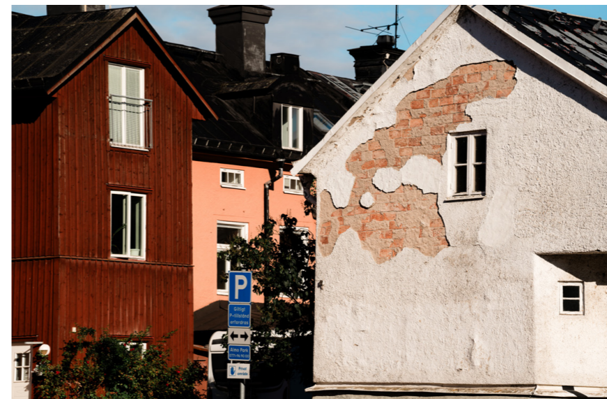
Exempel på tak på äldre byggnader.
