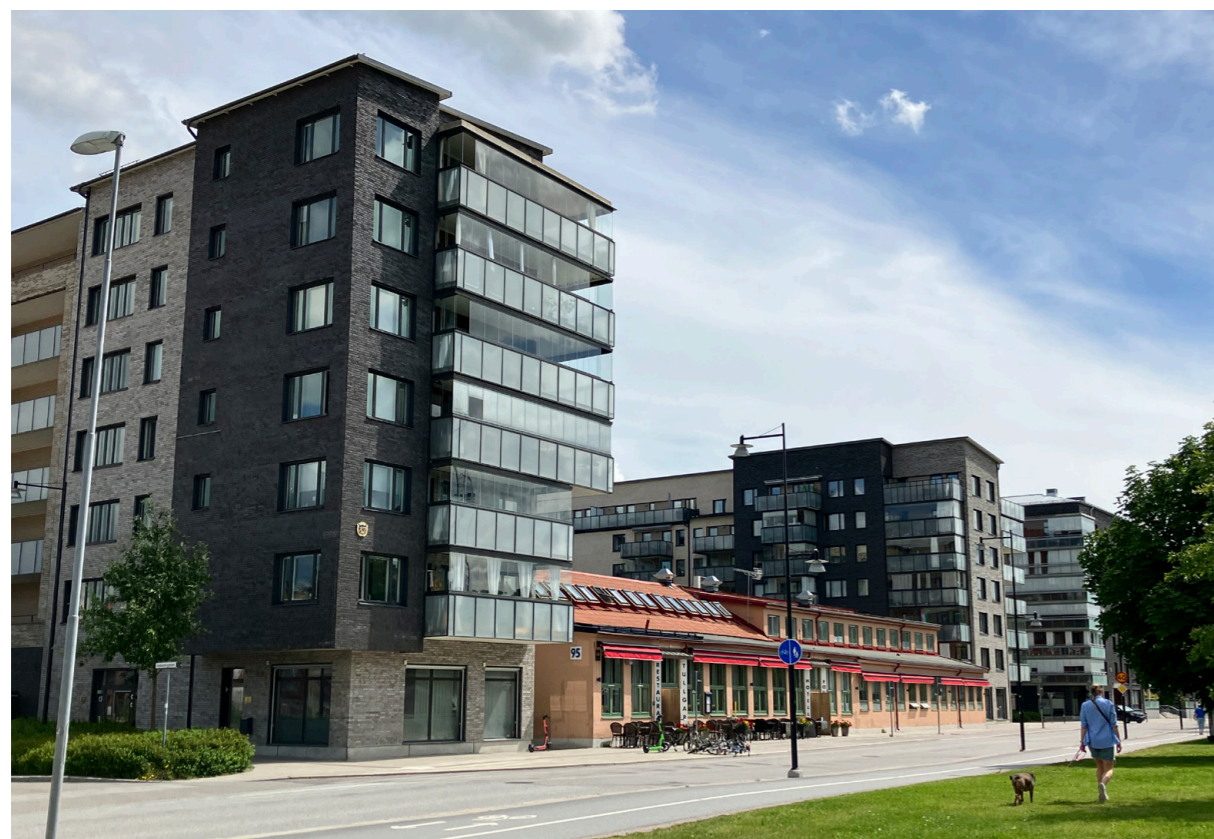
Exempel på nybyggnation och bevarandet av delar av den gamla bebyggelsestrukturen i Kungsängen.
