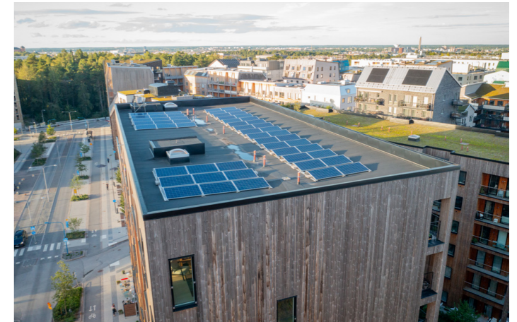
Exempel på solceller på taket.
