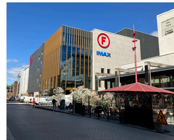
Ny bebyggelse i befintlig struktur längs Dragarbrunnsgatan.
