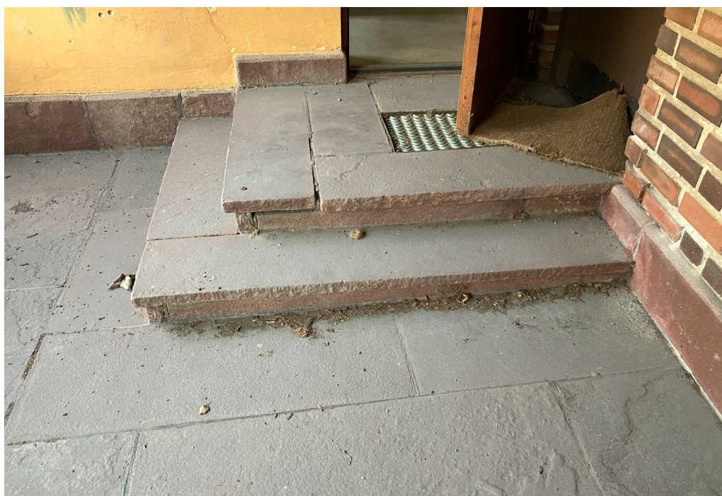
Figur 21 foton visar loggians golvbeläggning av röd kalksten samt tegelvägg som ska bevaras. Det säkerställs med skyddsbestämmelse q1.
