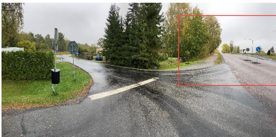
Figur 9. Busshållplats, refug och korsningsmöjlighet av 282 för fotgängare. Foto: WSP
