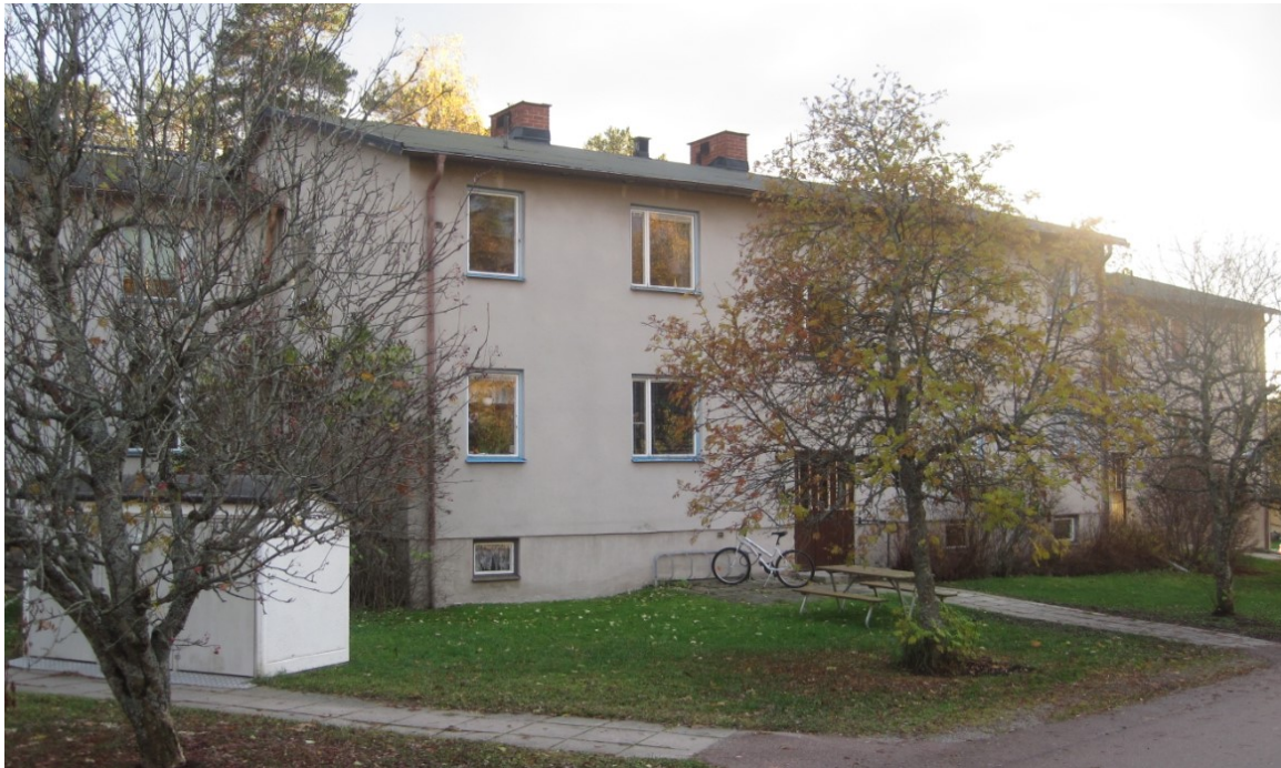
Vy från Lillsjövägen mot söder. På bilden syns entrésidan av flerbostadshuset inom planområdets östra del (Almunge Prästgård 1:51).
