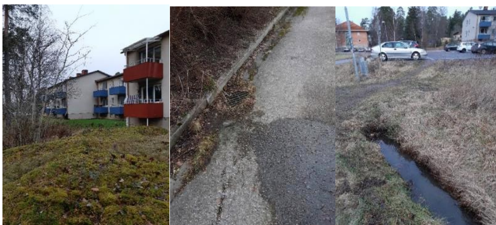
Figur 7. Bilder från genomfört platsbesök 2020-01-17.
