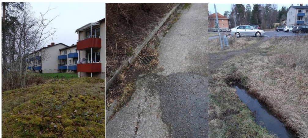
Figur 7. Bilder från genomfört platsbesök 2020-01-17.
