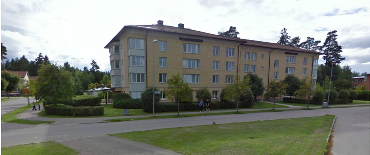
Planområdet sett från Västgötareisan mot sydväst med vårdboendet i fronten.
