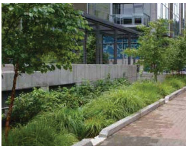
Figur 7: Parkering och köryta avvattnas mot växtbäddar.
