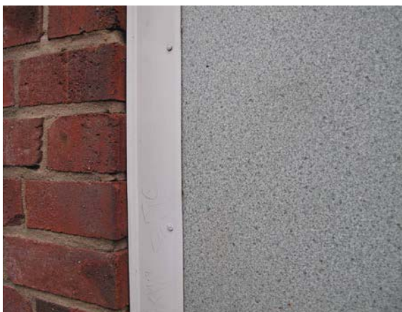
Mineritskivor i stenimiterande färg som ersatt de gamla eternitskivorna.
