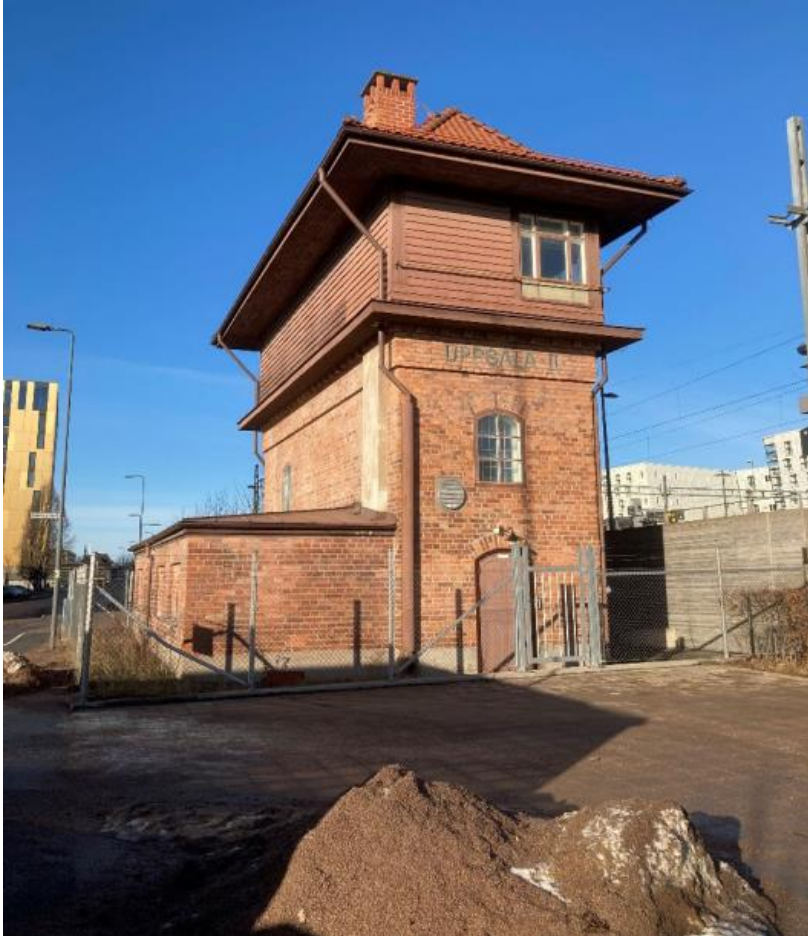
Ställverket är idag placerat intill järnvägen och instängslat.
