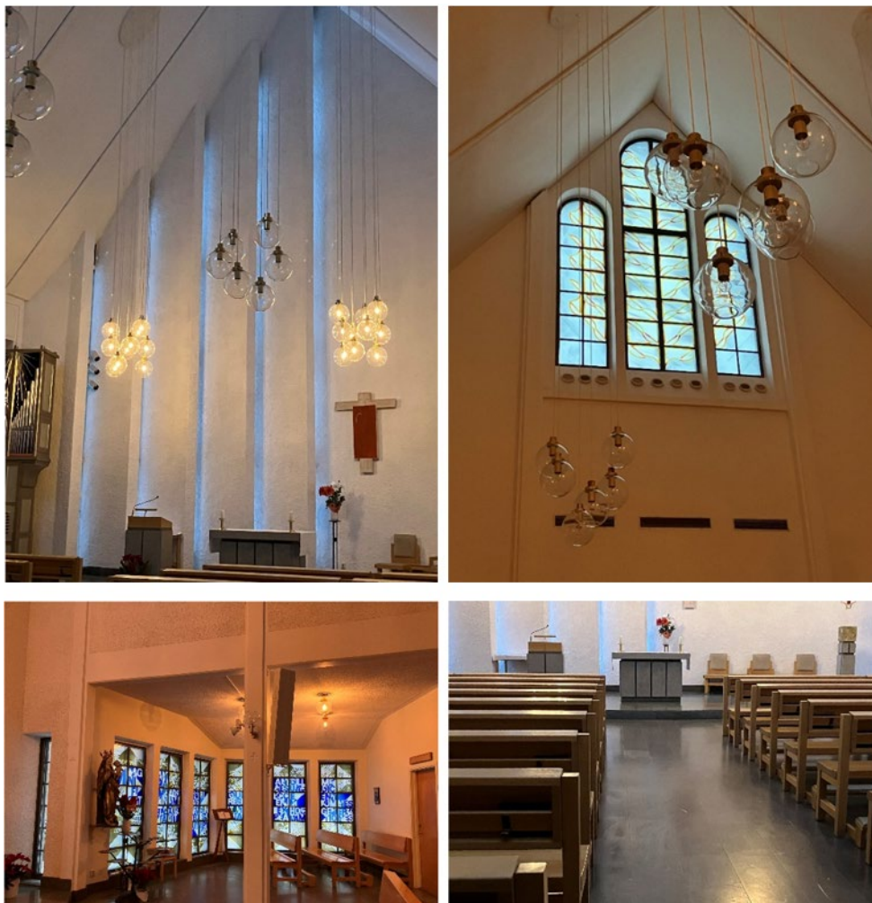
Figur 31 Bild som visar inrednings-och fasaddetaljer i kyrksalen: väggen i koret med snedställt ljusinsläpp (bild längs upp till vänster), rundbågiga spröjsade fönster (bild längs upp till höger), långsmala vertikala glaspartier (längs ner till vänster), och den öppna karaktären med fristående pelare och golvet (längs ner till höger). Källa: Uppsala kommun.
