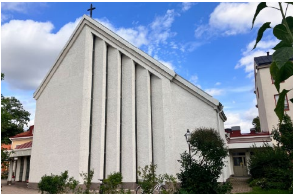
Figur 32 Kyrksalens västra gavel har ett veckat fasadparti. I respektive vinkel finns ett långsmalt glasparti som sträcker sig vertikalt över fasaden. Byggnaden har ett karaktäristiskt tak. Källa: kulturmiljöanalys, White arkitekter.
