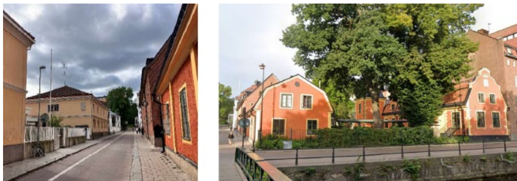
Figur 35 Nuvarande entrén till planområdet, vy från Slottsränd (vänster) och Ambrosiabyggnaden och Västgöta nations hus (höger) vilkens sammanhållna kulturmiljö upplevs i huvudsak från årummet. Källa: Antikvarisk konsekvensbeskrivning, White arkitekter.
