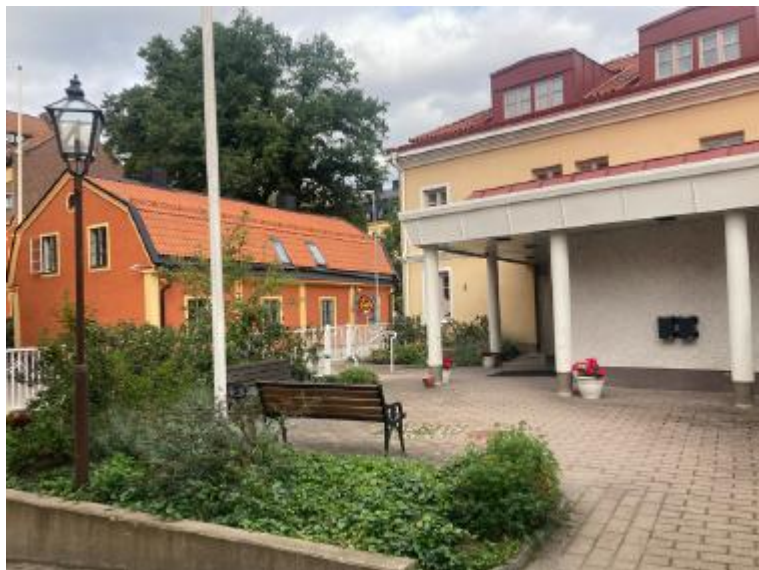
Figur 15 Bild tagen från innergården mot lågdelen med entréhallen. Lågdelen skapar en välavvägd övergång mellan gårdsrum och byggnad. Olika volymverkan och exteriöra material och kulör ger ett varierande uttryck. Skärmtaket bärs av kolonner utmed fasaden. Källa: kulturmiljöanalys, White arkitekter.
