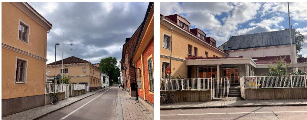
Figur 10 Nuvarande entré till Katolska kyrkan S:t Lars är indragen från gatan och har en nivåskillnad mot gaturummet. Källa: Antikvarisk konsekvensbeskrivning, White arkitekter.
