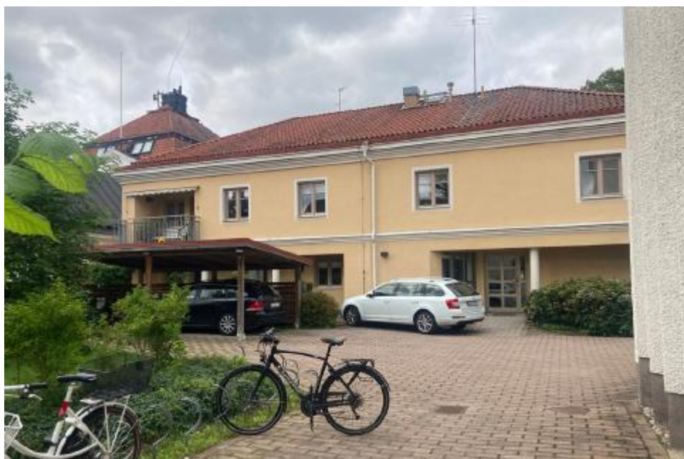
Figur 35 Byggnaden Systrarnas hus sett från gården. Byggnaden har glest placerade fönster och indragna fasadpartier på bottenplan samt en indragen balkong på det övre planet. Källa: kulturmiljöanalys, White arkitekter.
