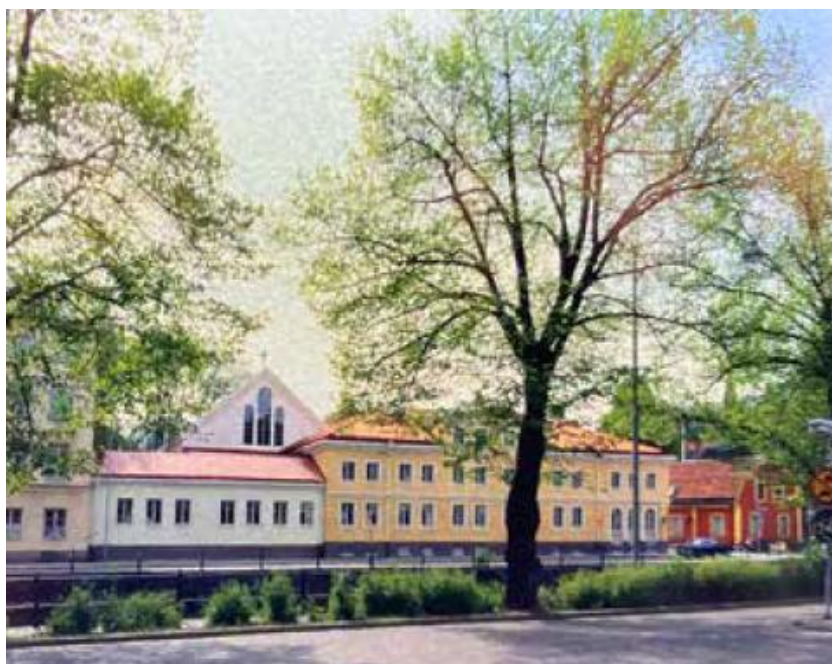
Figur 14 Foto som visar anläggningen mot årummet. Byggnadernas varierande karaktär bygger vidare på bebyggelsemiljöns varierande karaktär tillkommen vid olika tidsskeden. Källa: S:t Lars församling.
