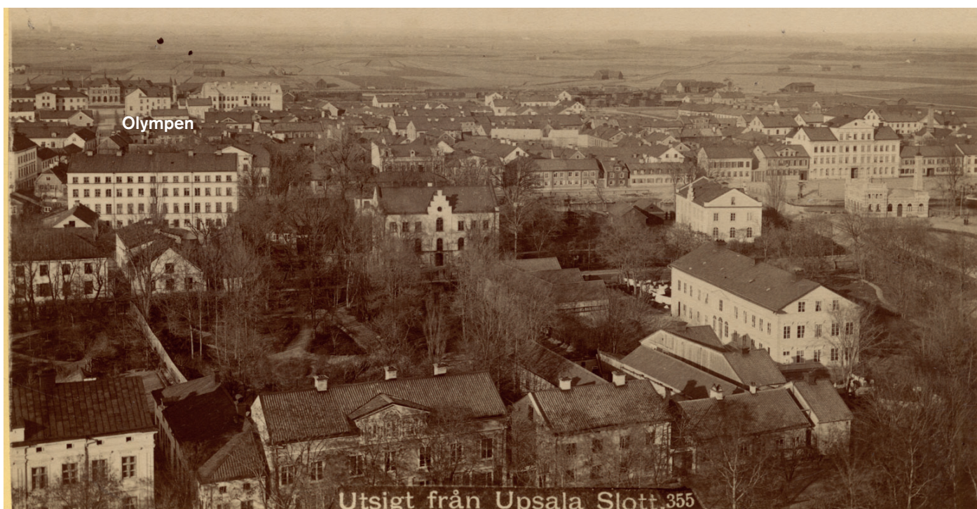
Vy över kvarteret Munken från slottet. I mitten syns institutionsbyggnaden för anatomi med trappgavel på huvudfasad, före flyglarnas tillbyggnad 1881. Den höga byggnaden till vänster är bostadshuset kallat Olympen. Foto: Lindahl Axel. Källa: Alvin
