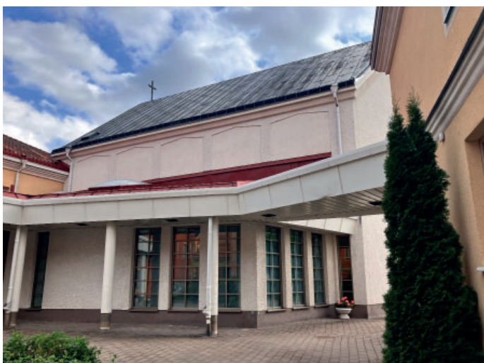
Kyrkosalens norra långsida med blindingar. Sidoskeppet mynnar ut i lågdelen. Sidoskeppet har spröjsade glaspazier. Kyrkosalen har ett plåtklätt tak med äldre dimensioner på plåten.
