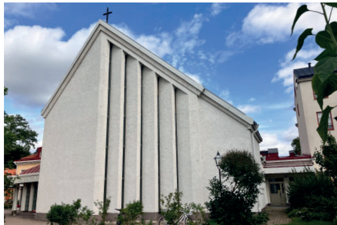
Kyrkosalens västra gavel har ett veckat fasadparti. I respektive vinkel finns ett långsmalt glasparti som sträcker sig vertikalt över fasaden. Byggnaden har ett karaktäristiskt tak.
