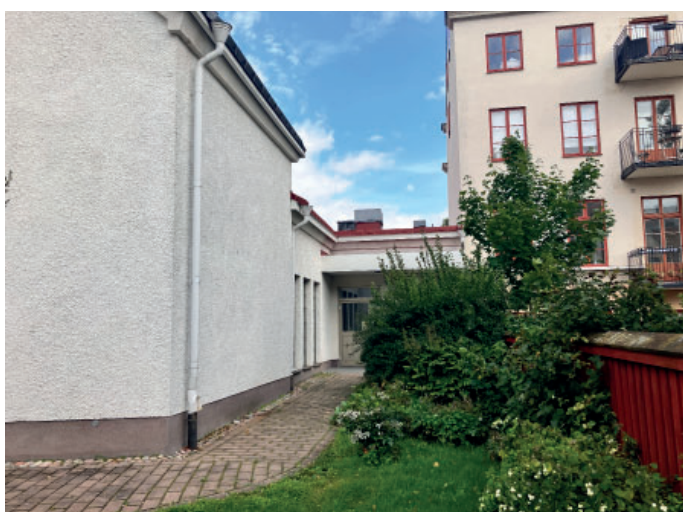
Kyrkosalens södra långsida har ett stramt uttryck. De sprit-putsade fasaden avslutas med en gesims. Sidoskeppet markeras med spröjsade glaspazier.
