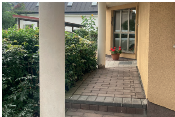
Indraget fasadparti med entré på Systrarnas hus. Det indragna fasadpartiet bärs av pelare liksom det anslutande skärmtaket. In- till entrén finns ett glaspazier med karmar och bågar i guldfärgad aluminium.
