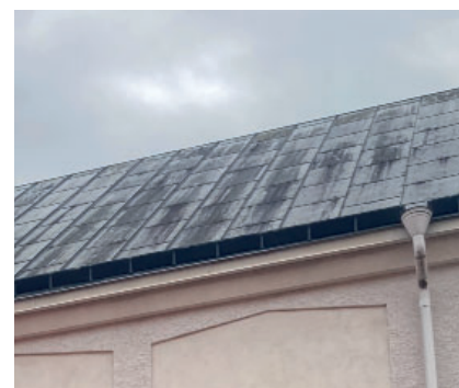
Skivtäckning av plåt med äldre dimensioner.
