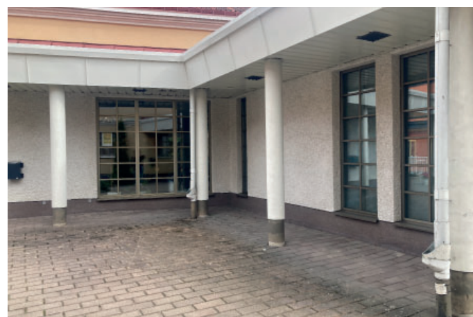
Till lågdelen ansluter ett skärmtak som löper utmed fasaden. Skärmtaket bärs av pelare. Undertill har skärmtaket plåtpaneler med ribbor. Lågdelen har stora spröjsade glaspazier.
