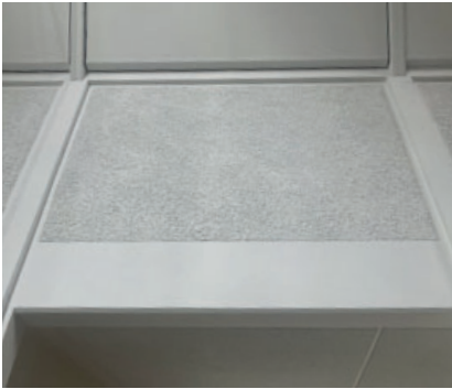
Spritputsade tak- och väggpartier.
