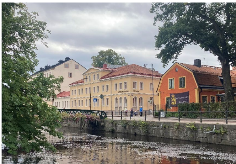
Riksintresset Uppsala stad (C40) tillkom drygt två år efter att Sankt Lars Katolska kyrkan flyttat till nuvarande placering. Vid uppförandet låg fokus på det postmodernistiska uttrycket och den mindre skalan. Byggnaden mot än lånar drag från tidigare bebyggelse (Imperfektum).
