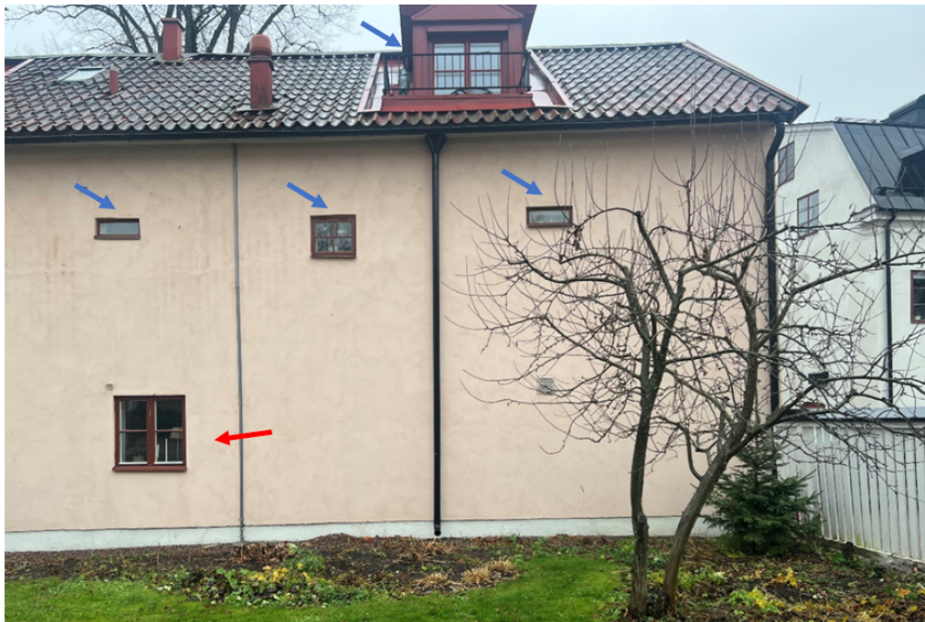
Figur 2 Längsgående fasad av huset som ligger på fastigheten Fjärdingen 30:5, direkt intill planområdet. Fönster, takkupa och utrymningsbalkong mot det föreslagna byggnad D markeras med blåa pilar och en röd pil.
